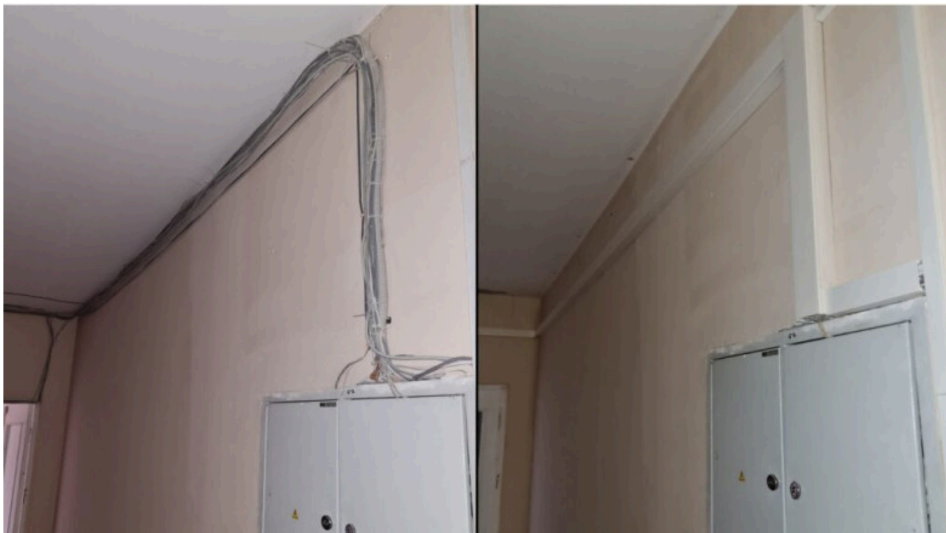
Фото из интернета до и после монтажа кабельного канала
